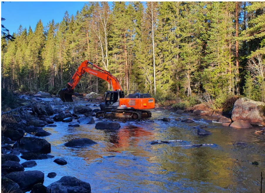
Figur 2 Grävmaskin i arbete vid flottledsåterställning i Ängerån, Ljusdals kommun.
