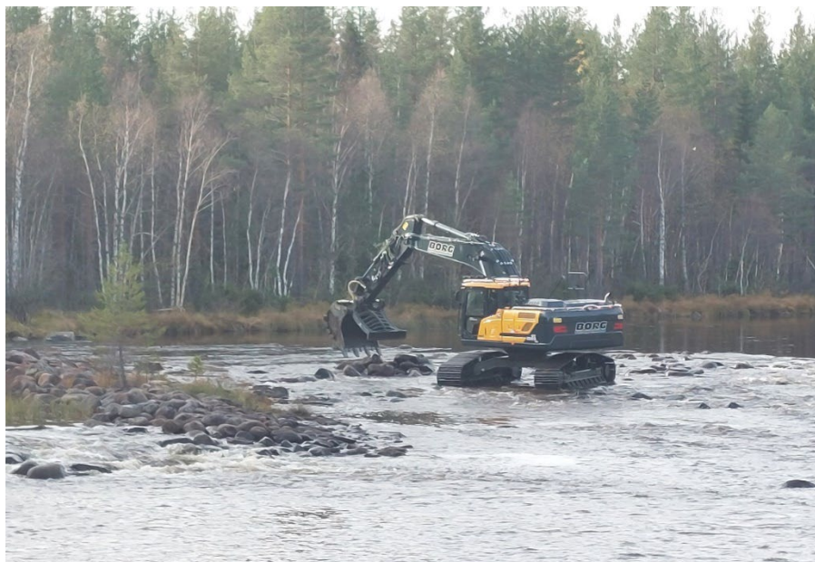
Figur 1 Grävmaskinen jobbar med en uppbyggnad av en bestämmande sektion i Voxnan, Ljusdals kommun.
