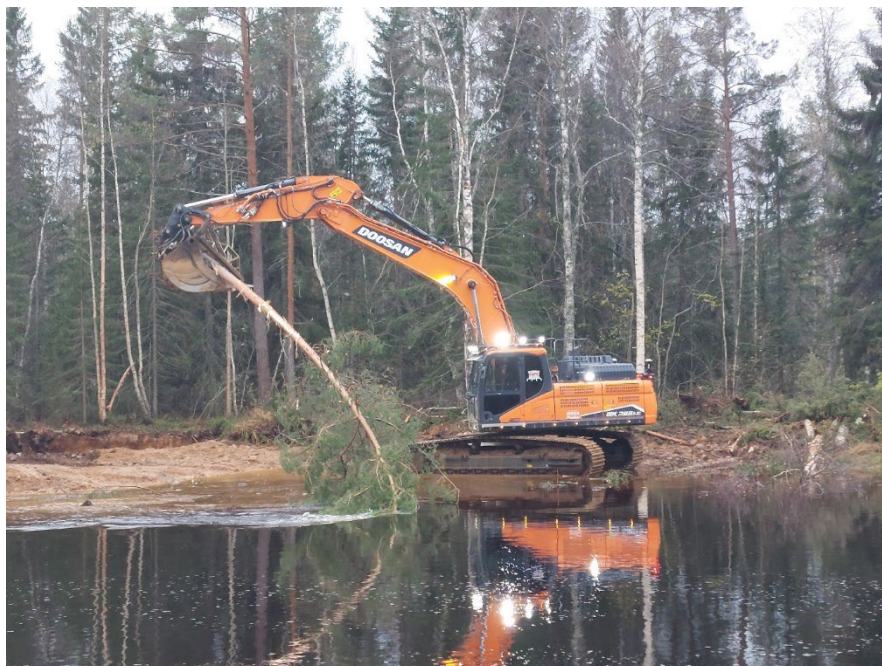
Figur 4 Ett träd som växt på uppschaktat bottensubstrat avverkas och återförs sedan som död ved i vattnet.
