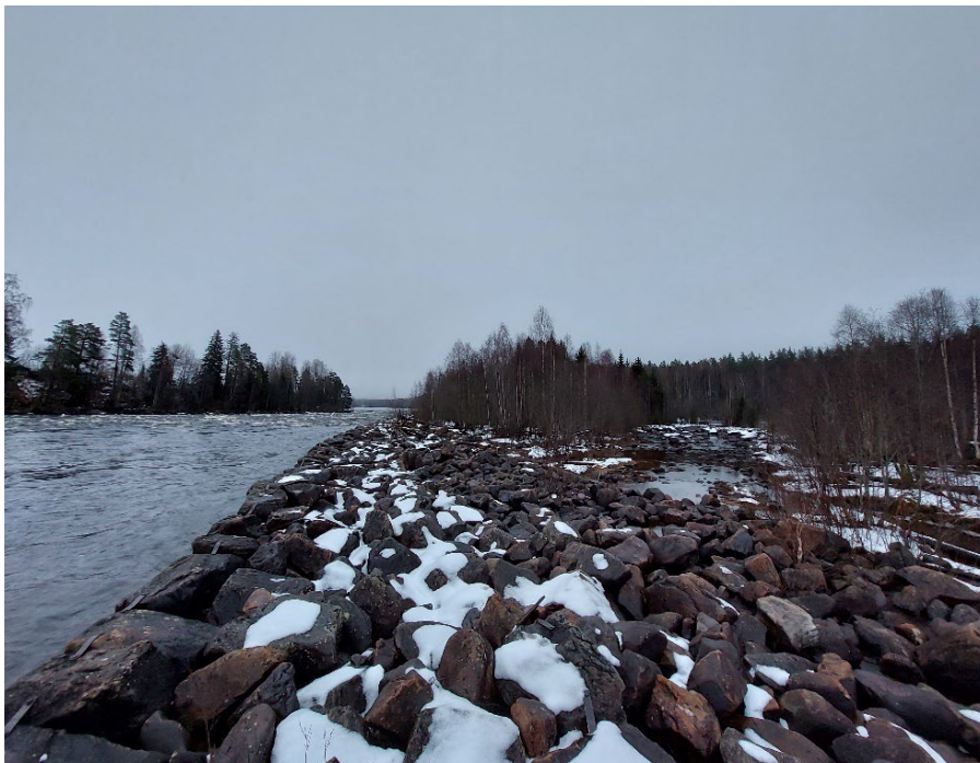
Figur 19 Den stora stenkistan/ledarmen i Henriksforsen som hindrar älven att rinna runt ön. Denna (Färila 263) kommer tas bort i projektet och de upprepade blocken används i restaureringen i huvudfåran
