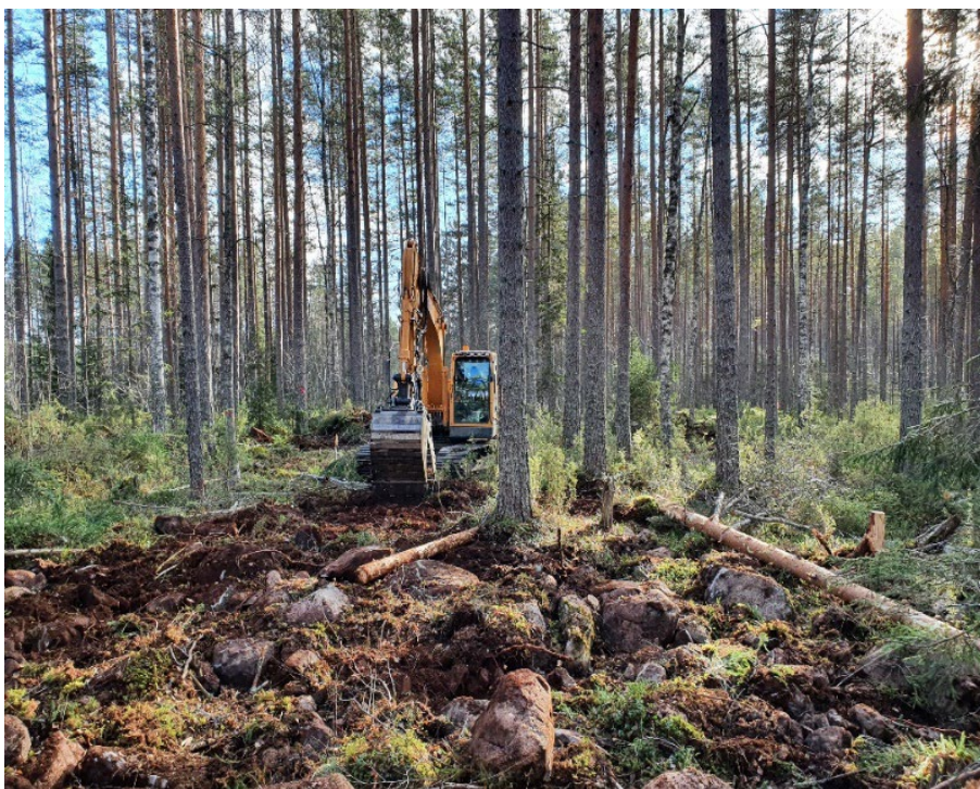
Figur 3 Grävmaskin som markavtäcker överväxt sidogren.
