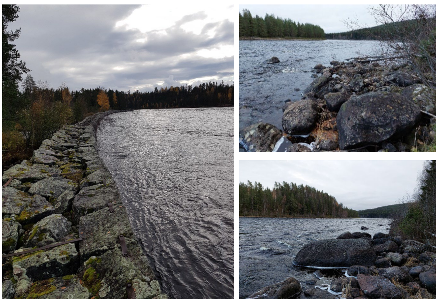
Figur 12 Till vänster stenkista (Färila 253) vid Brännholmen. Övriga: Karaktäristisk bild på uppschaktade block i strömmarna mellan Kölströmmen och Brännholmen som kommer användas i restaureringen.
