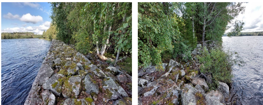
Figur 14 En huggen stenkista (Färila 256:2) som stänger av en av sidofårorna. Denna tas bort i projektet och mer vatten släpps in i sidofårorna.
