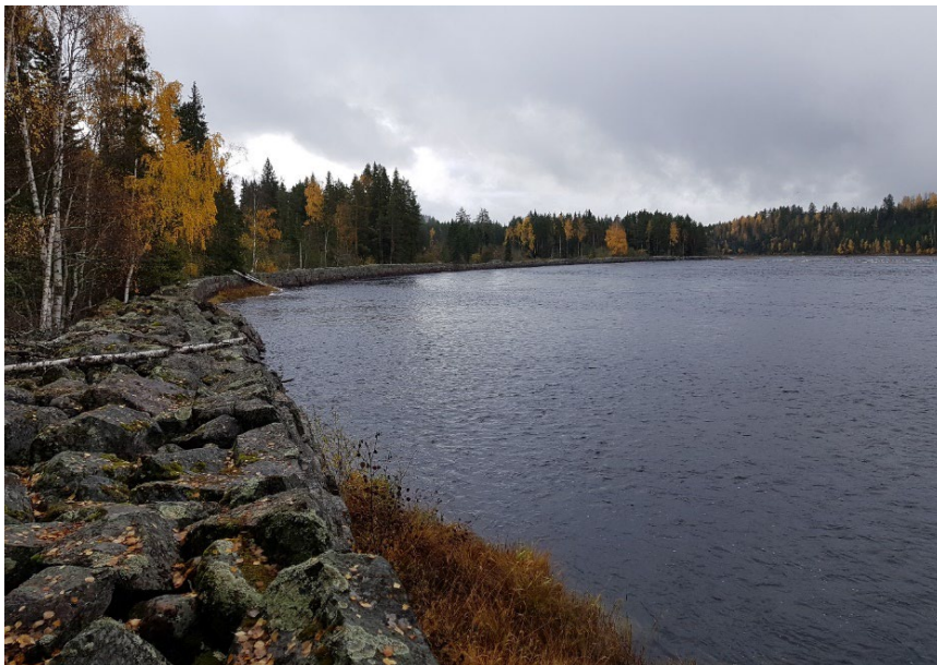
Figur 11 Den huggna stenkistan vid Kölströmmen (Färila 248:1) som inte kommer åtgärdas i projektet.
