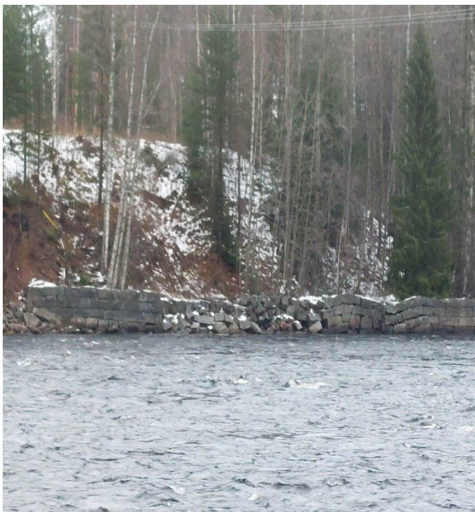
Figur 17 Den delvis raserade kistan på den norra sidan av älven. Denna lämnas orörd i projektet.
