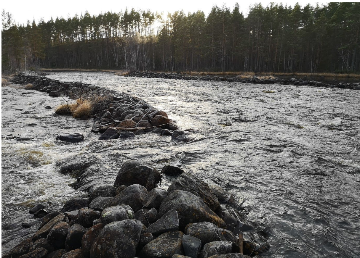
Bild 29. Uppschaktade vallar i Hylströmmens nedre del. Vallen närmast i bild är delvis öppnad
