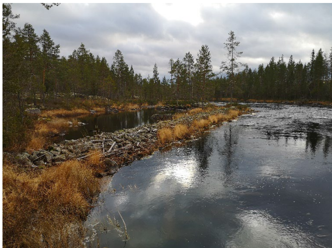
Bild 7-8 Visarvallar som kanaliserar vattendraget. Schaktvallen på bilden till höger hindrar vattendraget att rinna ut i en sidogren.
