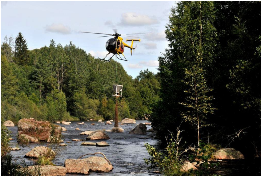
Bild 2. Exempel på utläggning av lekgrus med hjälp av helikopter
