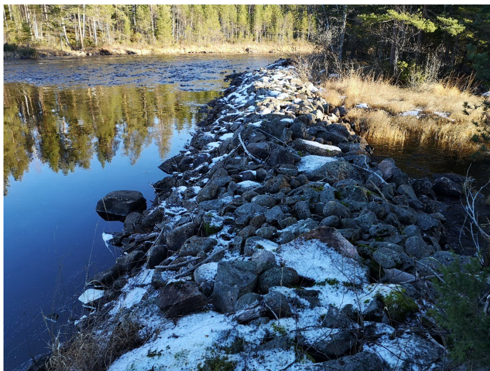
Bild 19. Schaktvall i strömmen nedströms Lappstreken. Vallen hindrar vattnet att rinna runt ön och kanaliserar Voxnan.
