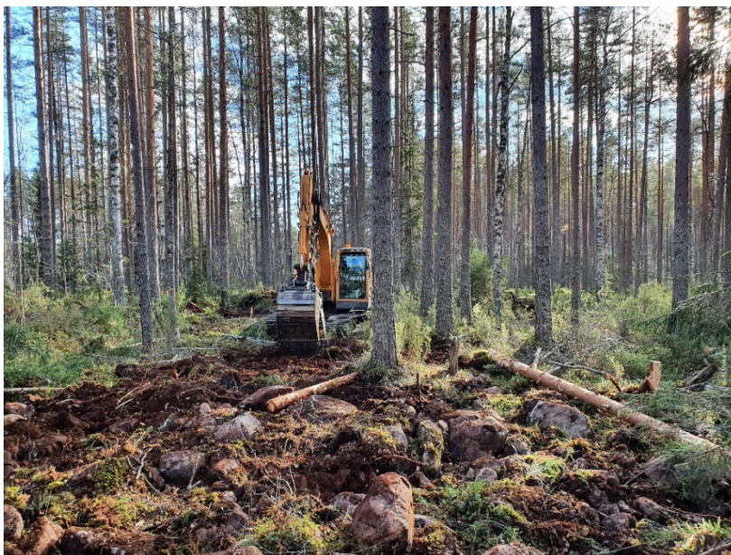
Bild 3. Bild på grävmaskin som markavtäcker överväxt sidogren
