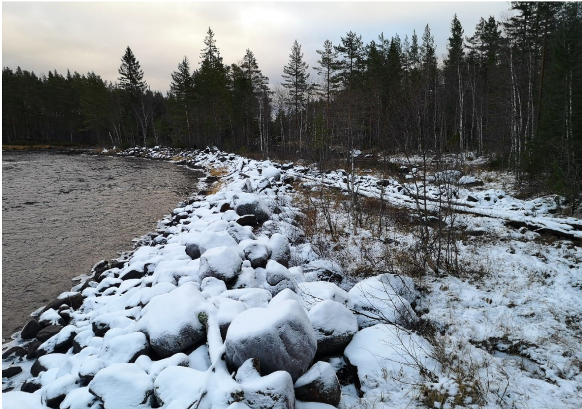
Bild 23. Schaktvall i Stentagsströmmen som stänger av en naturlig fåra
