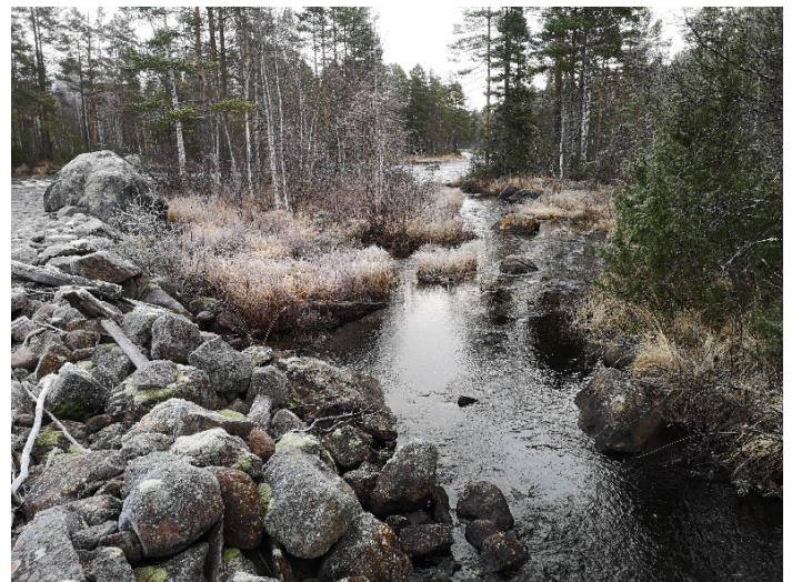
Bild 31 Uppschaktad vall som delvis stänger av en sidofåra längs åtgärdssträcka 5B.
