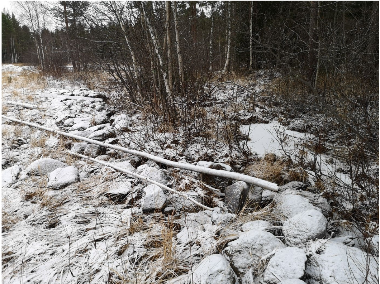
Bild 38. Schaktvall som stänger av en gammal kurva i Voxnan.
