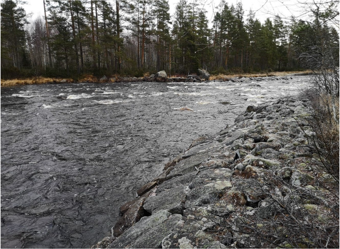
Bild 32 Delvis invallad sträcka i den mellersta strömmen längs åtgärdssträcka 5B
