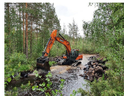
Bild 1. Pågående restaureringsarbete i Västerhocklan, Ljusdals kommun. Foto: Länsstyrelsen Gävleborg.
