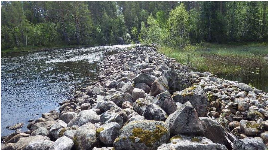
Bild 4. Exempel på stenvall som stänger av en sidofåra i bild 5 nedan. Den bör öppnas upp för att skapa liv i sidofåran som är relativt bred och orensad.
