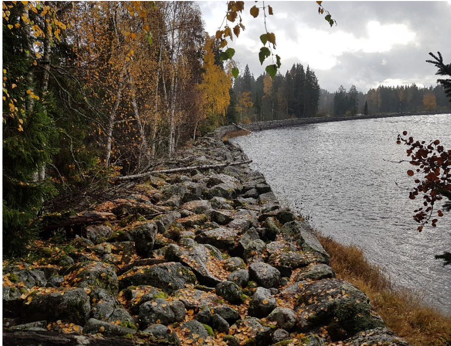
Bild på den huggna stenkistan vid Kölströmmen, Ljusnan.
