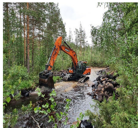
Bild 3. Pågående restaureringsarbete i Västerhocklan.
