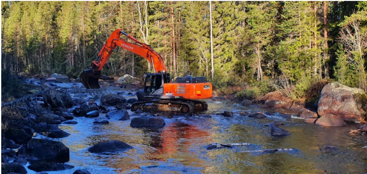
Bild 1 Grävmaskin som återställer en sträcka av Ängerån i Ljusdals kommun, Gävleborgs län. Foto: Anders Persson, Länsstyrelsen Gävleborg
